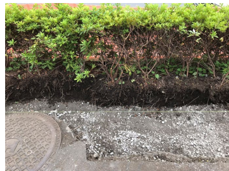
根詰まりによる土壌の浸透能の低下
