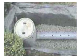
雨水浸透トレンチ
