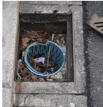
道路浸透ますの内部状況の確認
